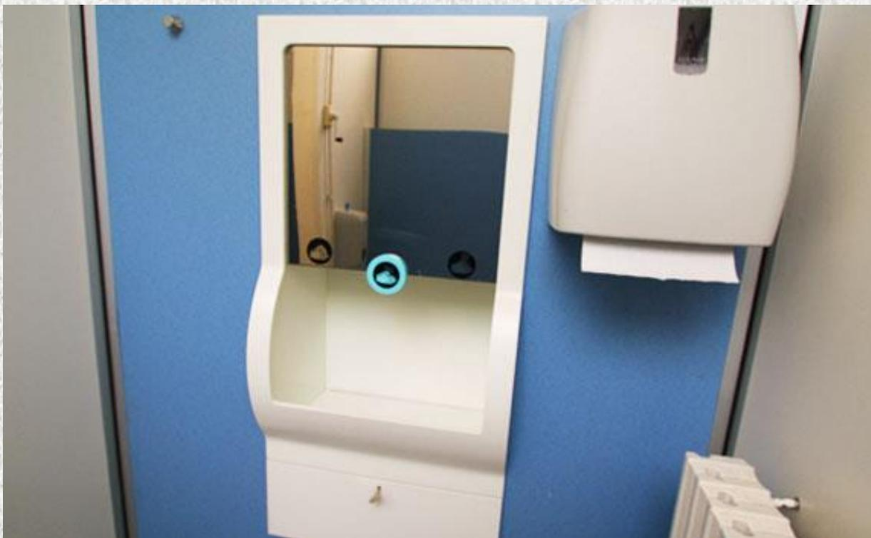
**H2air** è un lavandino automatizzato, antivandalo, con erogatori elettronici no-touch per la fornitura di acqua, sapone e aria calda.
